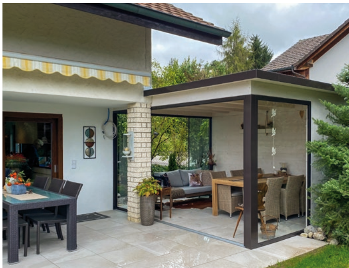
Diese BERNA Terrassenlounge Typ «Light» wurde seitlich an das Haus angebaut.
